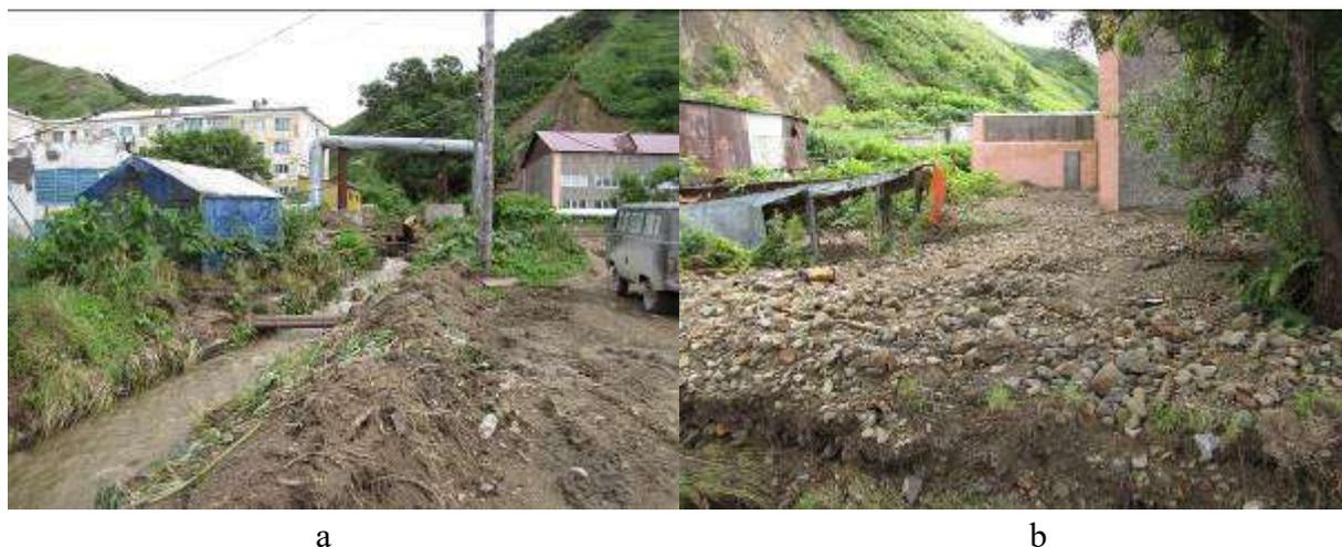
**Рисунок 2.** Селевой ручей в городе Невельск (2010 г.): зарегулированное русло ручья после схода селя (а) и селевые отложения за пределами бетонного лотка (b)
