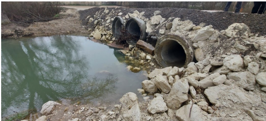
Рисунок 2. Дамба в районе вершины устья р. Черной в межень
