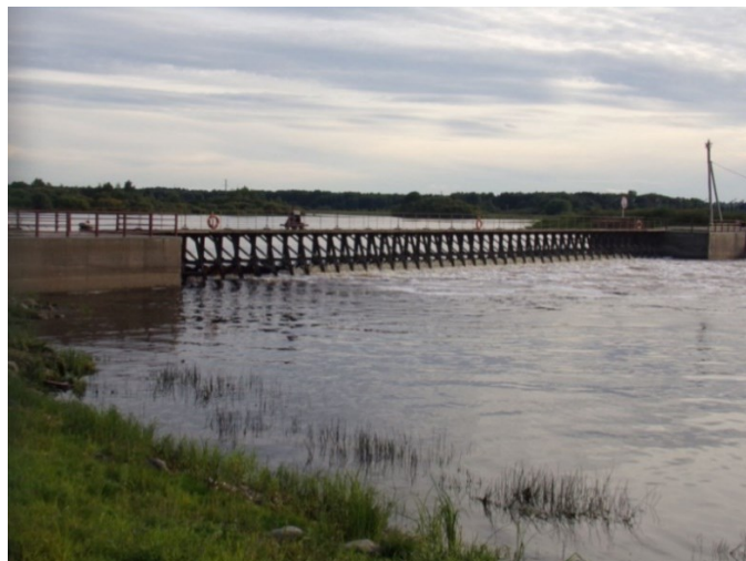
Рисунок 4. Подпорная плотина ПОАРЭ шлюза Знаменитый СДШС. Вид с нижнего бьефа (фото автора)
